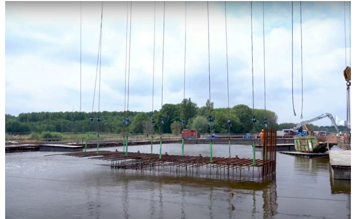
Afbeelding 2 inhijzen wapeningskorven
