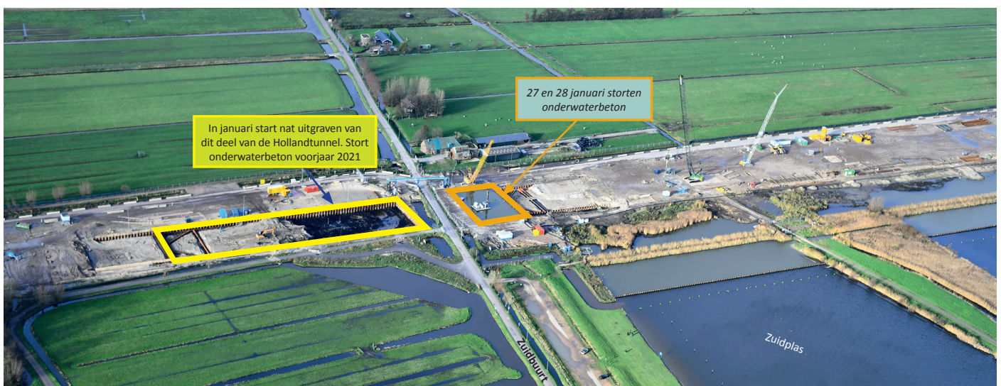
Afbeelding 1 locatie werkzaamheden Hollandtunnel
