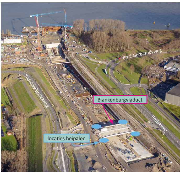
Afbeelding 1 Locatie aanbrengen heipalen
