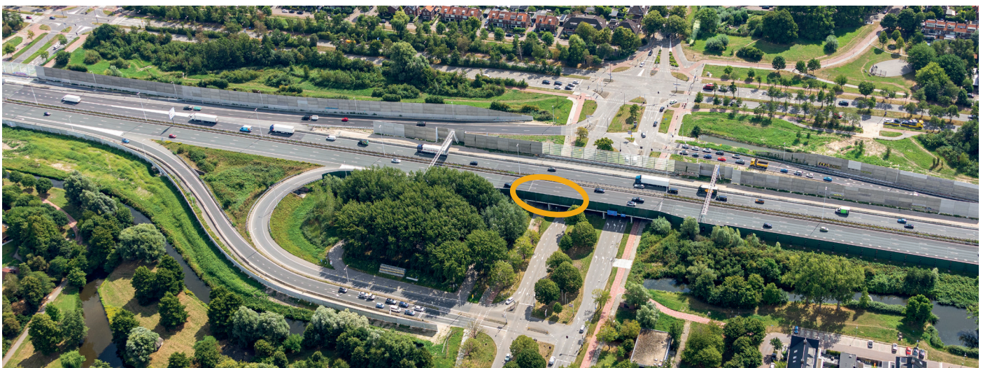
Afbeelding 1 Locatie tijdelijk te verwijderen geluidschermen viaduct Holysingel
