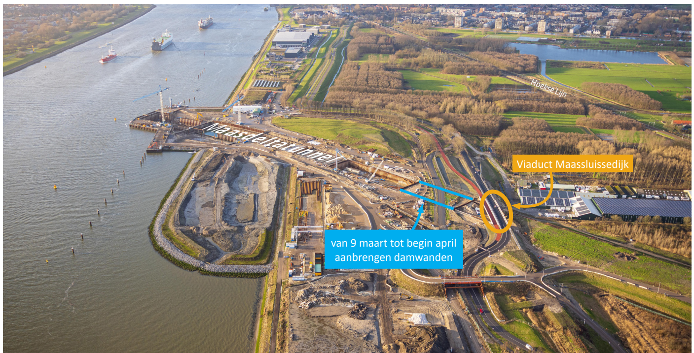
Afbeelding 1 Locatie damwanden Maasdeltatunnel
