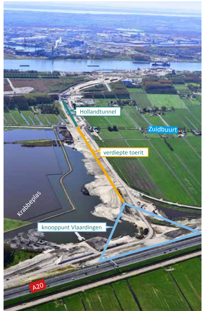
Afbeelding 1 Hollandtunnel, verdiepte toerit en knooppunt Vlaardingen
