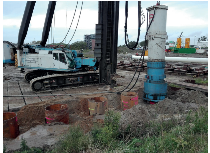
Afbeelding 1 Laatste buispaal Maasdeltatunnel zuid
