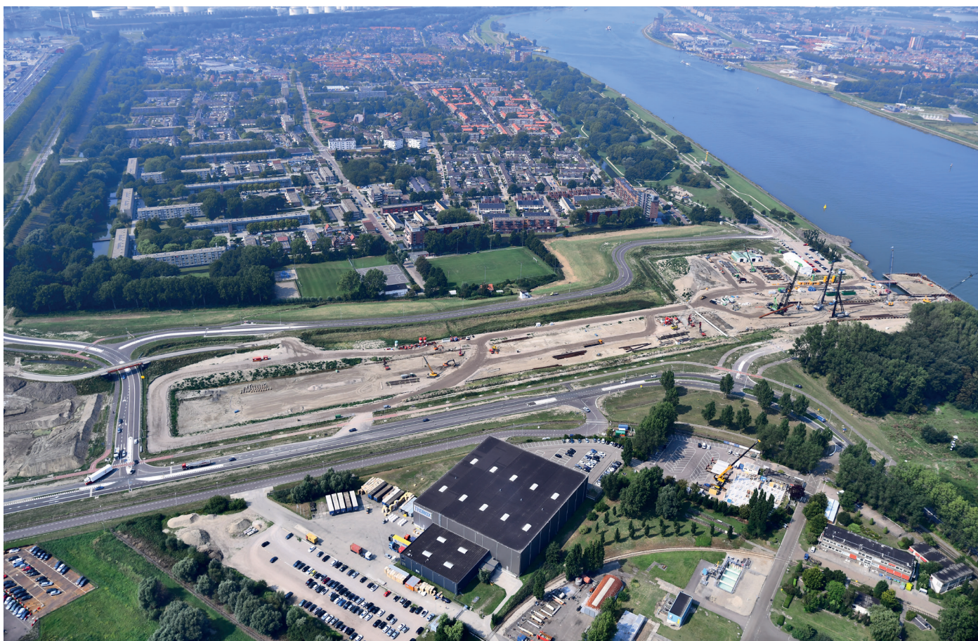
Afbeelding 3 Luchtfoto toerit Maasdelatunnel augustus 2019
