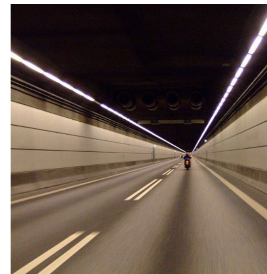
Helder verlichtingsbeeld tunnel
