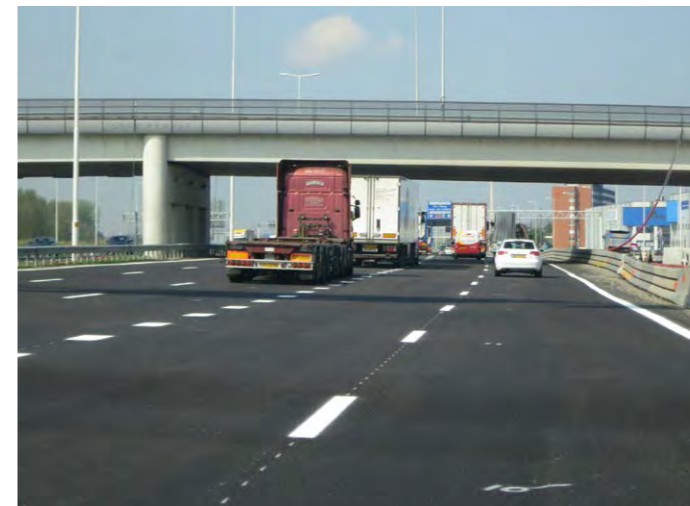
A15 MaVa viaduct
