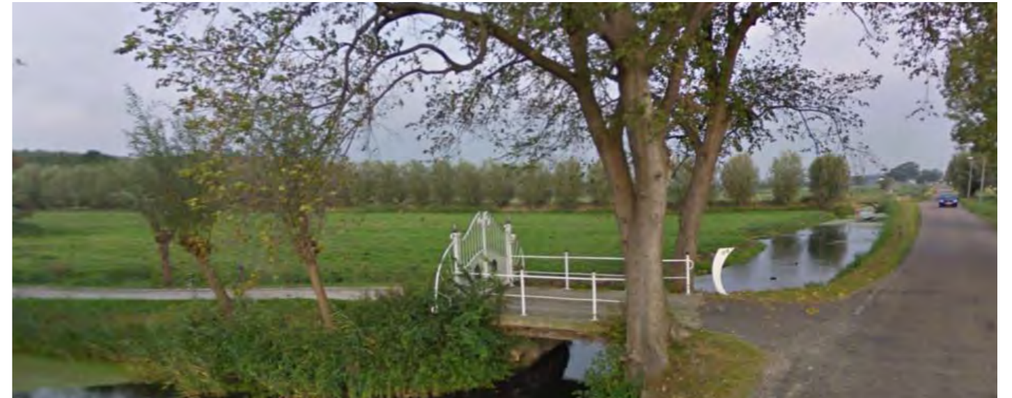
Bestaande kavelontsluitingsbrug langs Zuidbuurt
