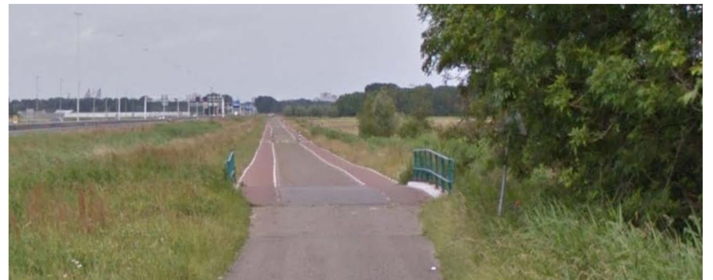
Bestaand bruggetje Broekpolderweg
