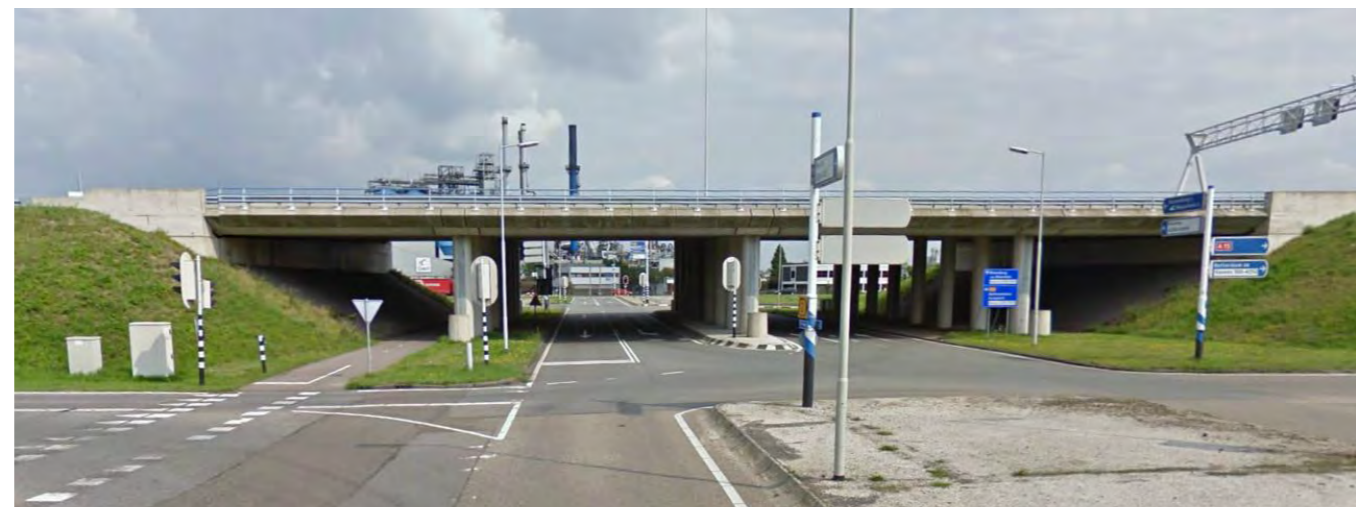
Viaduct A15 - Trentweg
