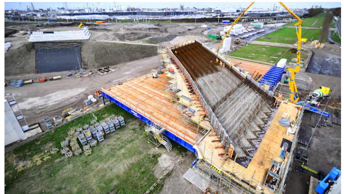
Afbeelding 1 Tafelconstructie met daarop betonnen dek bij Droespolderweg de fly-overs (zie afbeelding 3). De pijlers maken we in vier stappen (zie afbeelding 2):
