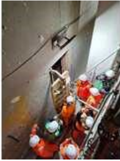
Openen deur laatste stuk Maasdeltatunnel.JPG
