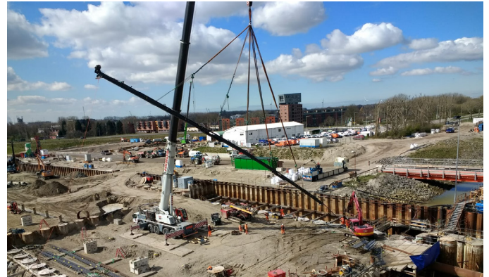
Afbeelding 1 Ankers aanbrengen voor stabilisering damwand
