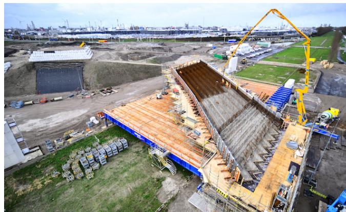
Afbeelding 5 Storten eerste beton 17 februari 2020
