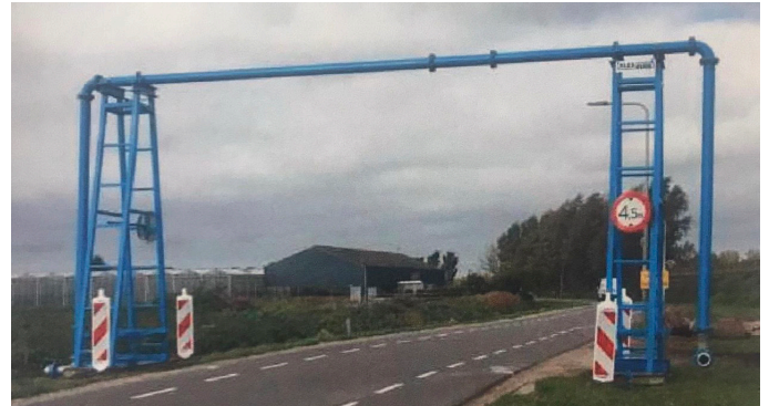
Afbeelding 2 voorbeeld van leidingbrug
