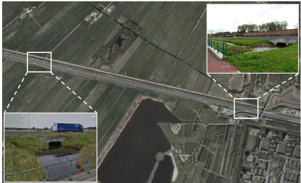
Afbeelding 7.1. Locatie vervanging duikers door ecoduikers
