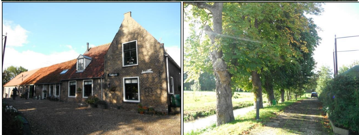
Figuur 4-1: boven het gebied waar op 10 oktober een quickscan Flora- en Faunawet is uitgevoerd. De boerderij bestaat uit een oud en nieuw deel (1 resp. 2), er is een loods aanwezig (3) en twee houten schuren (4 en 5), daarnaast vier paardenkastanjes (6) en een solitaire dikke linde (7). Onder twee foto's van de boerderij en de paardenkastanjes.
