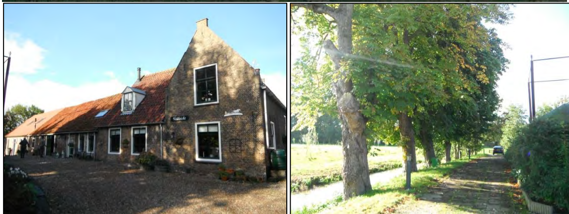
Figuur 4-1: boven het gebied waar op 10 oktober een quickscan Flora- en Faunawet is uitgevoerd. De boerderij bestaat uit een oud en nieuw deel (1 resp. 2), er is een loods aanwezig (3) en twee houten schuren (4 en 5), daarnaast vier paardenkastanjes (6) en een solitaire dikke linde (7). Onder twee foto's van de boerderij en de paardenkastanjes.
