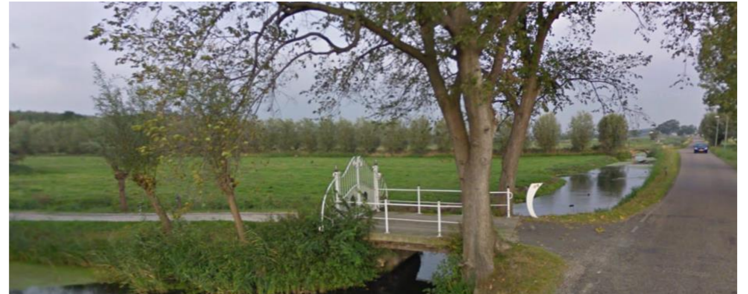
Bestaande kavelontsluitingsbrug langs Zuidbuurt
