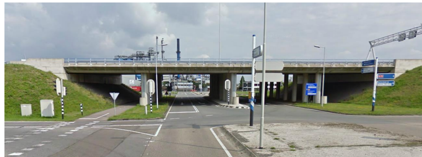
Viaduct A15 - Trentweg
