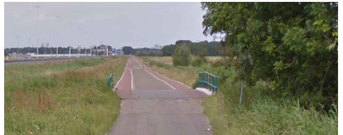
Bestaand bruggetje Broekpolderweg
