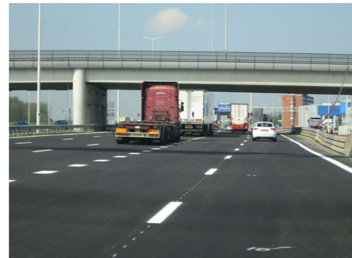
A15 MaVa viaduct
