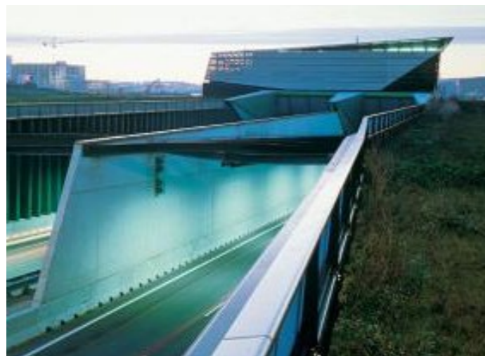
Tunnelmond en dienstgebouw ontkoppeld
