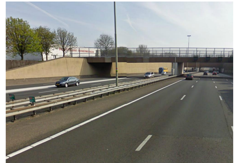
Betonnen middenberm, wanden
