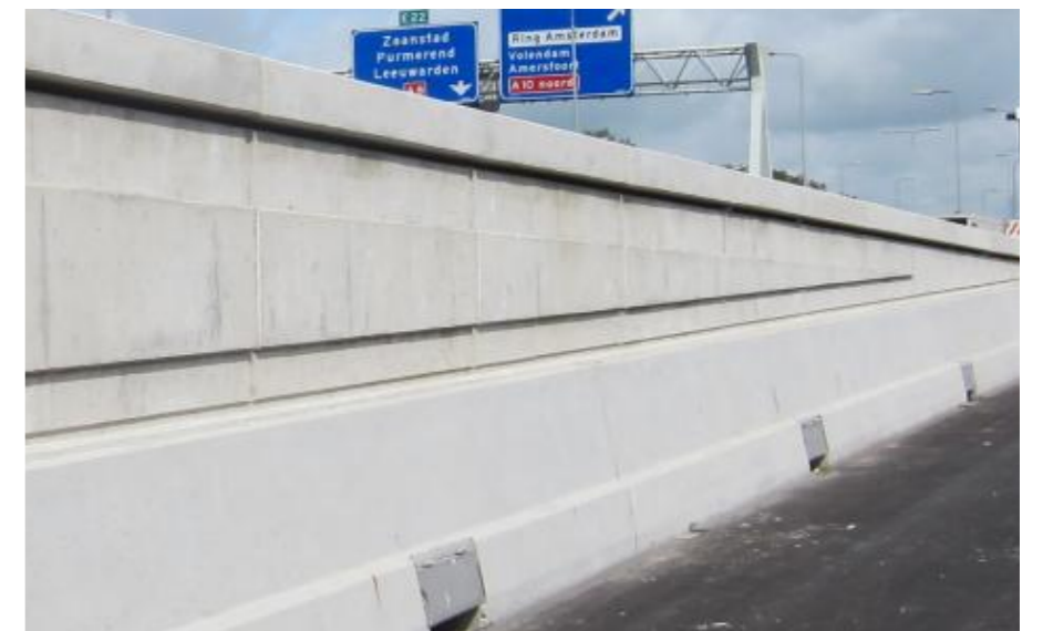
Beton barrier geïntegreerd in wand
