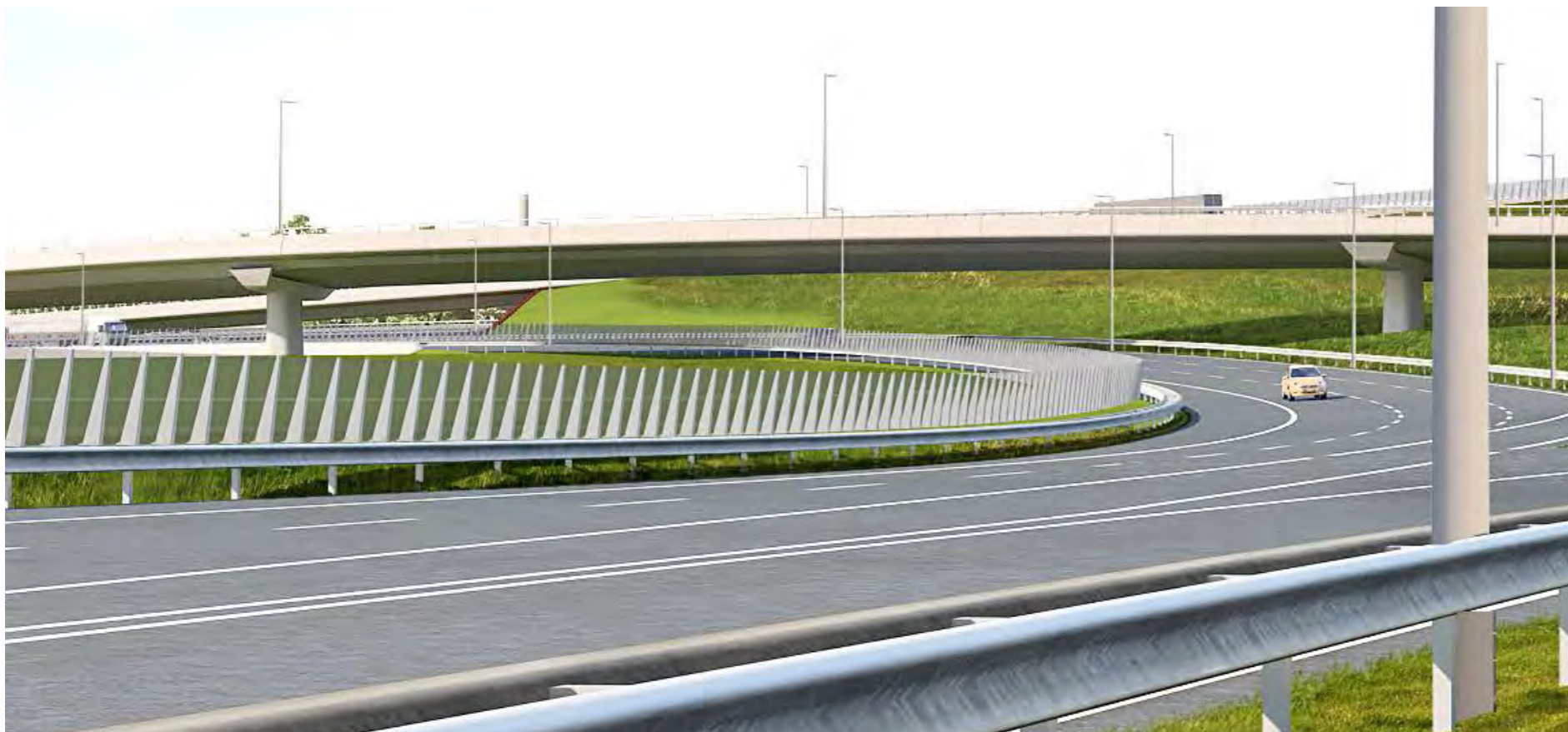
Geluidsscherm langs westelijke verbindingsboog A15 knoop
