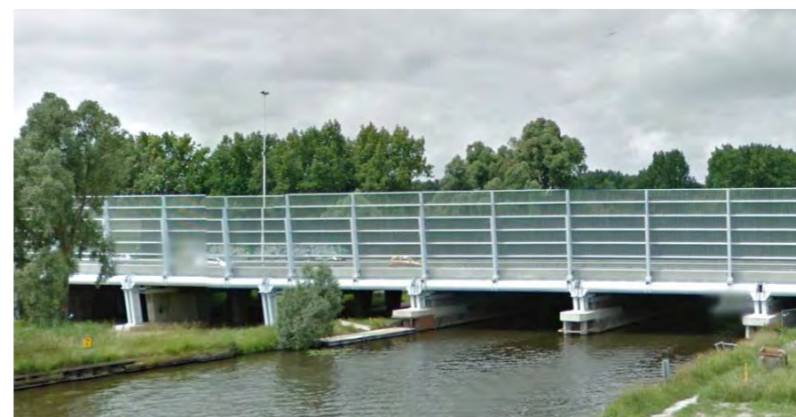
Glazen modulair scherm op viaduct Vlaardingervaart
