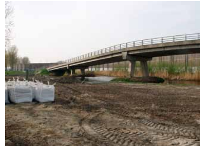
Viaduct naar de Broekpolder
