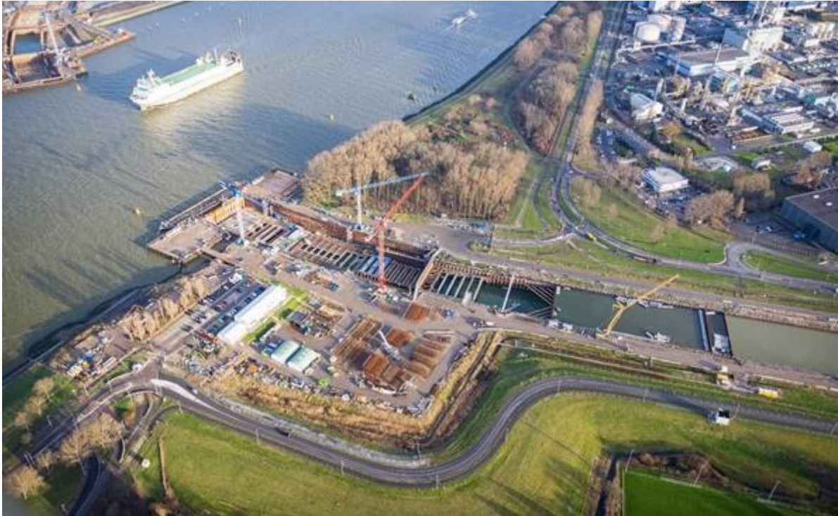
Toerit Maasdelatunnel, Rozenburg – foto Rijkswaterstaat
