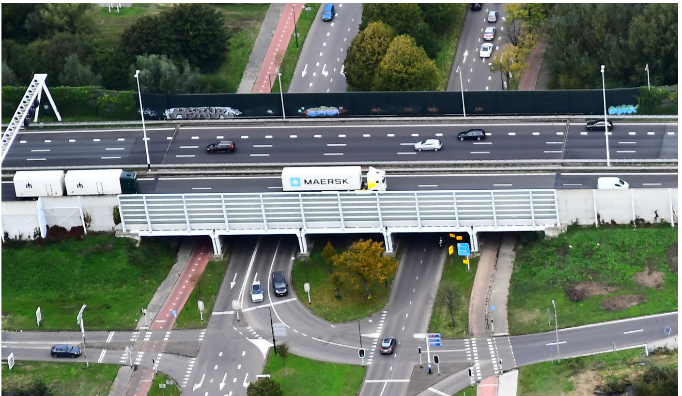
Afbeelding 1 Het viaduct over de Holysingel wordt gerenoveerd
